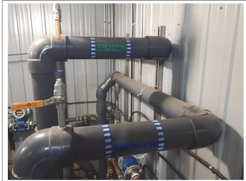
Photo 11 : Vue des conduites associées au temps de contact entre la station de pompage, traitement et distribution et le réservoir d'emmagasinement du secteur Les Buissons – 2020-05-21
