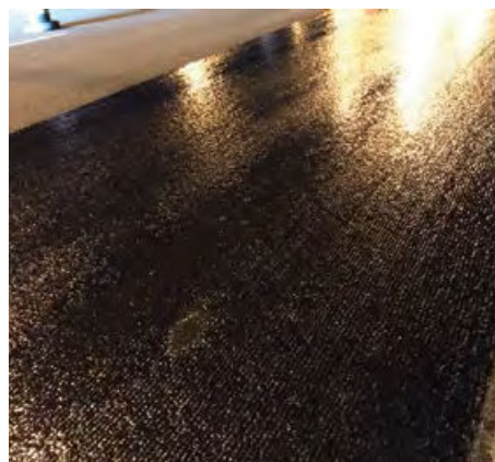
-Photo 2- Couche d'accrochage avant l'application du voile anti-collage.
