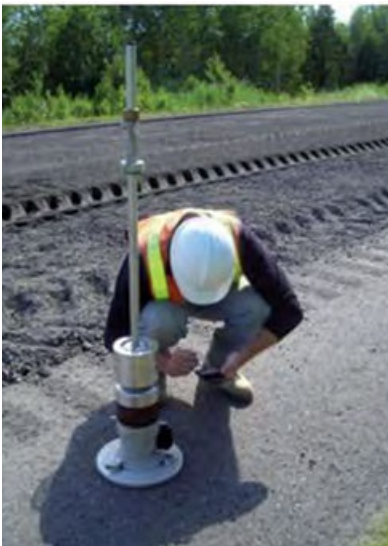
Figure 3 : utilisation du LWD en chantier (Depatie, 2013)
