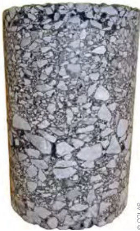
-Photo 5- Carotte extraite de l'A25 quelques mois après la mise en œuvre du BBUM pour mesurer l'adhésion des couches.
