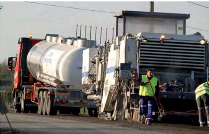
Figure 2.3 – Retraitement à froid en place
