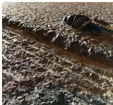
-Photo 1- Texture du micro-fraisage et redan de 20 mm aux abords de la coupe de fraissage.
