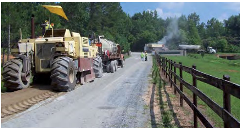
Figure 2 : opération de retraitement en place (The Miller Group, 2017)
