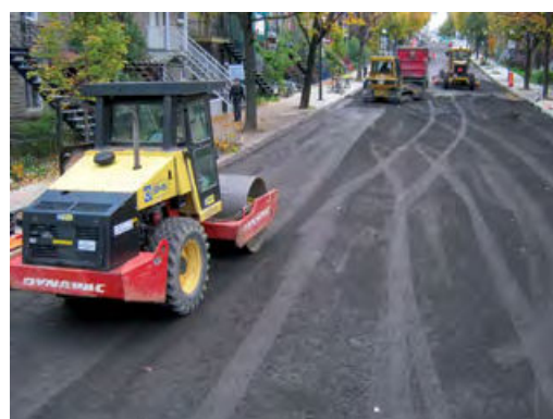
Image #2 – mise en œuvre de grave traitée en usine
