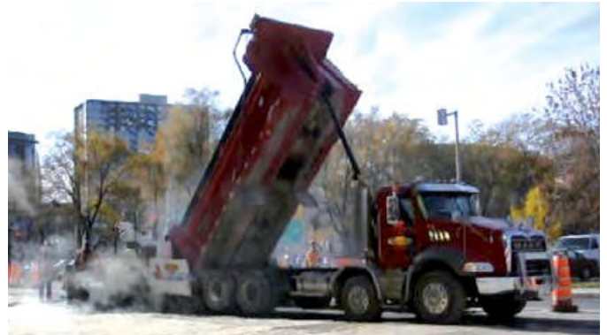
Figure 3.1 – Émissions de fumée lors d'une livraison d'enrobés à chaud traditionnels en chantier
