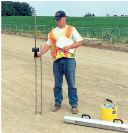
Figure 4 : utilisation du DCPT en chantier (Depatie, 2013)
